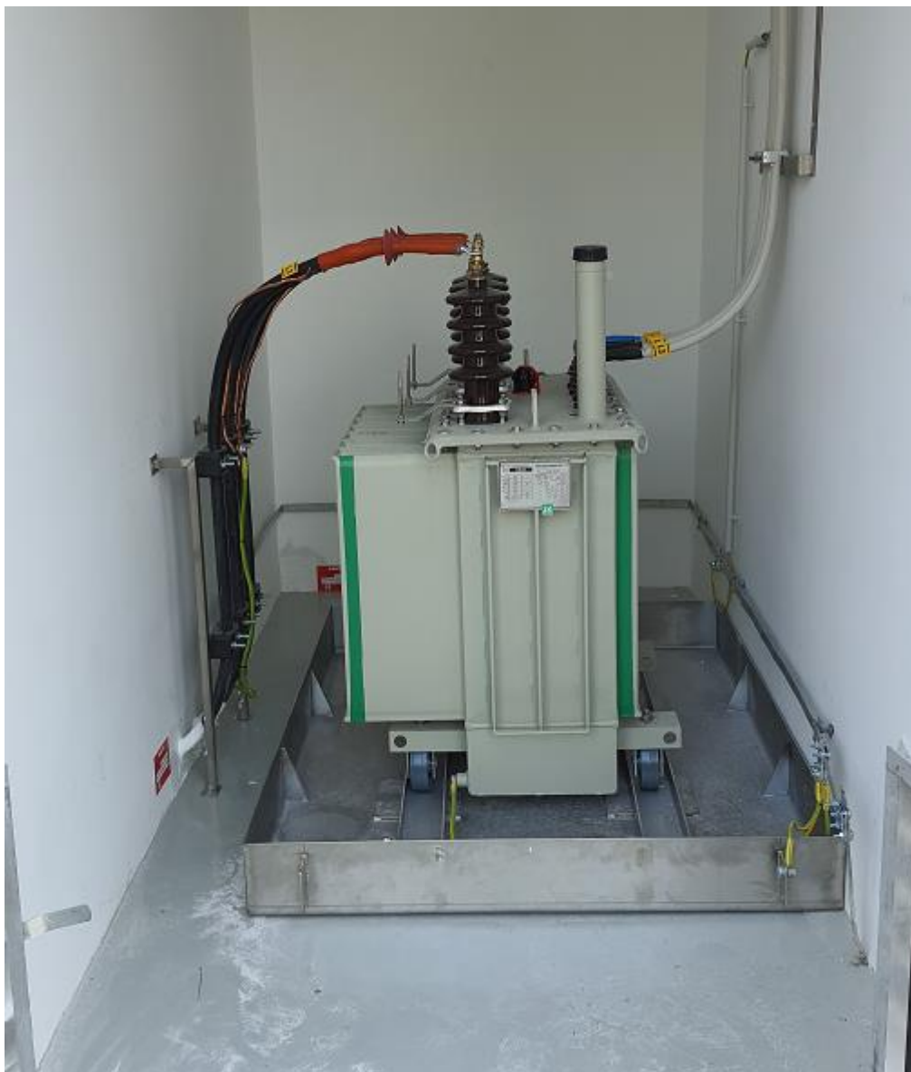
Slika 4-4: Primer vgradnje in montaže TR
